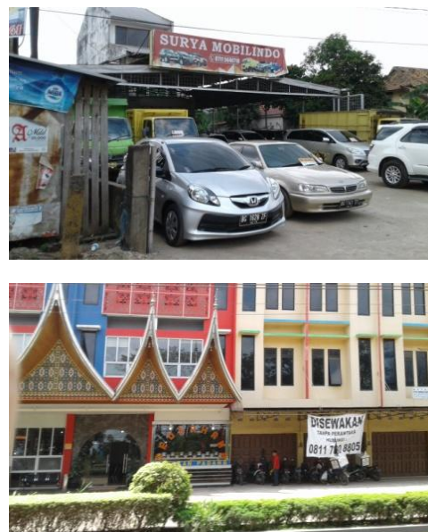
Gambar 4.4. Tampilan Fasade Bangunan Sumber : Analisa
